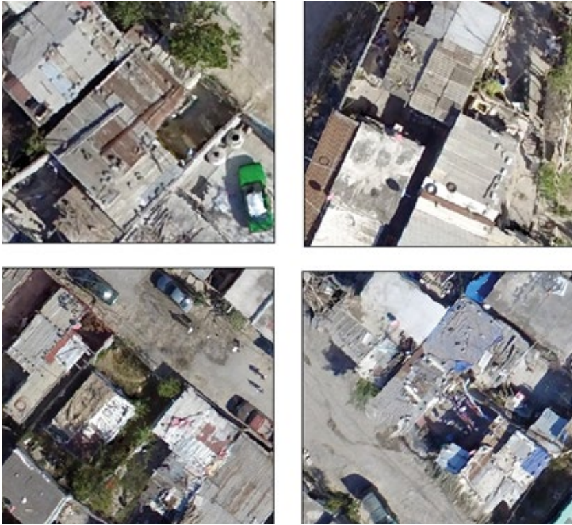
Figura 12. Condiciones de los techos de las viviendas en ladera “Las Pedreras”.
